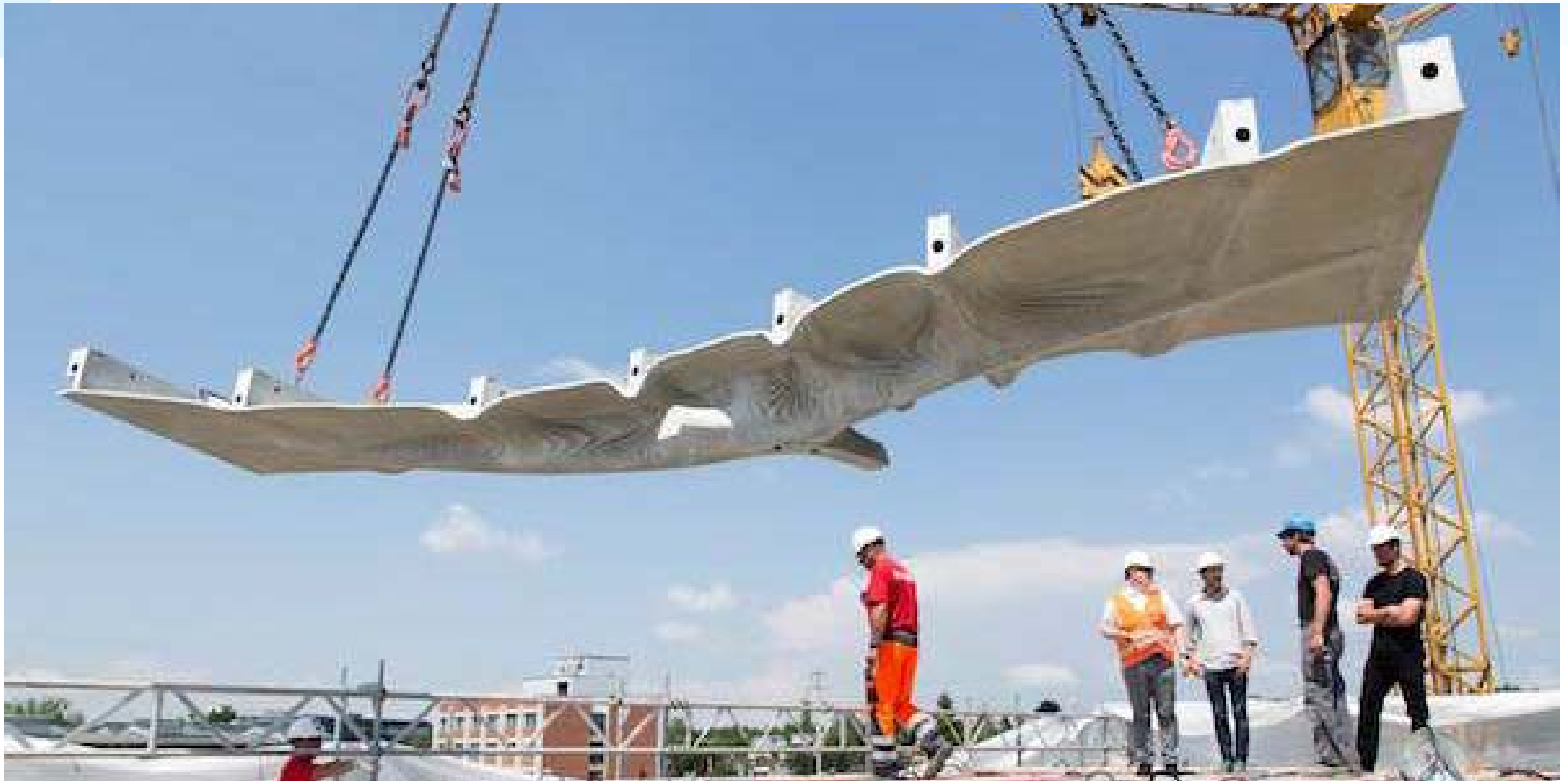
Betonelemente werden in Schalung aus 3D-Sanddruck gegossen (© ETH Zürich/Tom Mundy)
