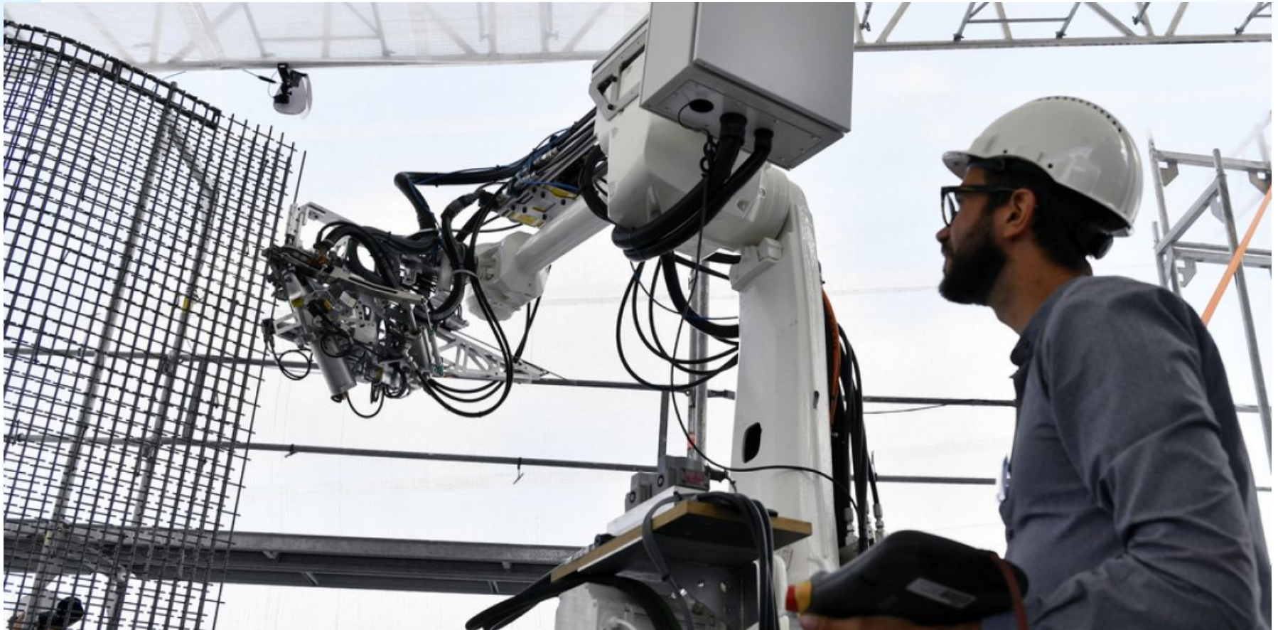
Der Bauroboter In situ Fabricator baut mithilfe der Mesh Mould Technologie ein Stahldrahtgitter ( © ETH Zürich)
