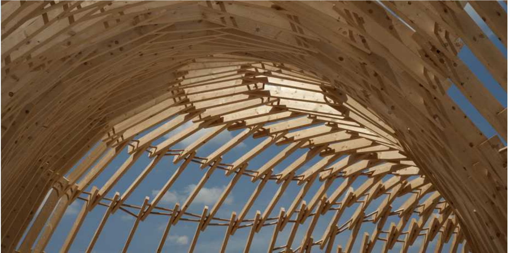
Die Konstruktion der Pergola kommt ohne Leim, Nägel oder Schrauben aus. (© Martina Cirese)
